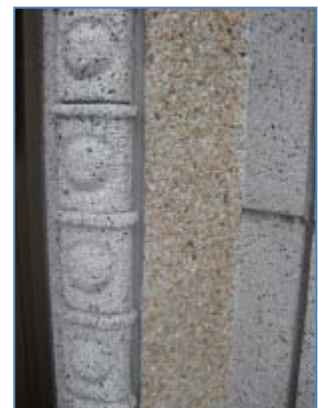
洗い出し工法による壁
